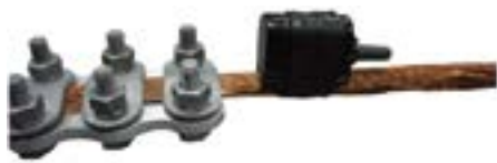
电气设备或线路连接点处安装传感器
